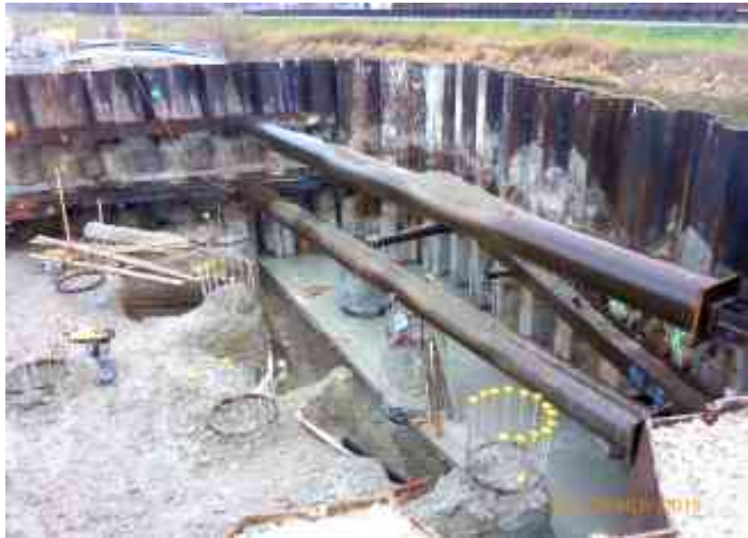
Bild 11 1. Pilgerschritt bei Achse 20
