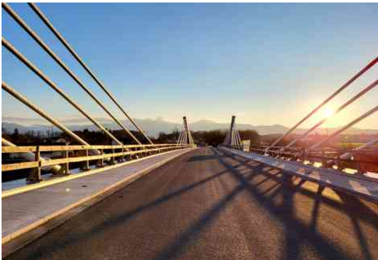
Bild 13 Autofahrerperspektive der fast fertigen Brücke
