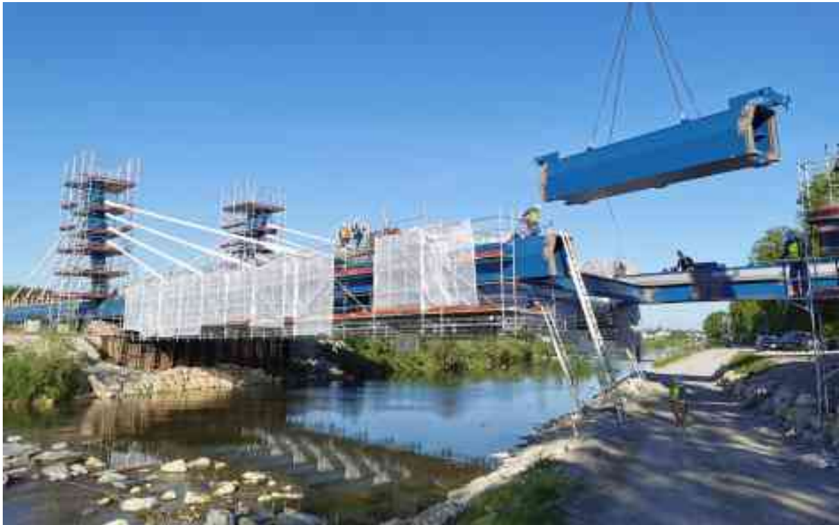
Bild 4 Lückenschluss Stahlüberbau
