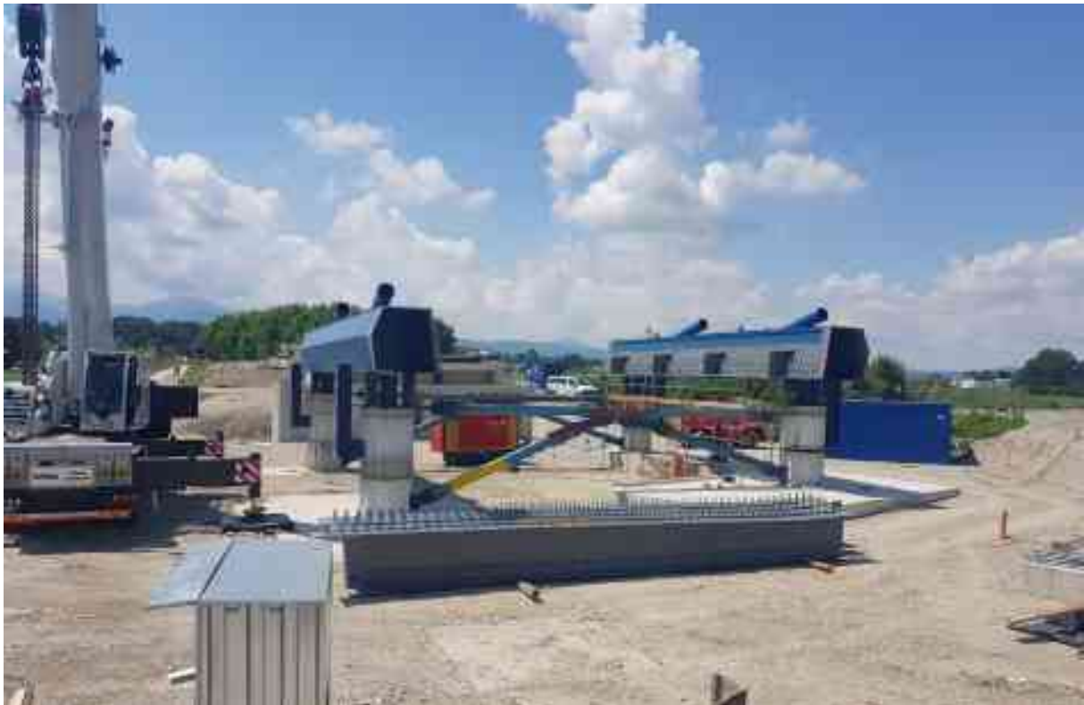
Bild 12 Die ersten Stahlbauschüsse sind auf der Baustelle angekommen
