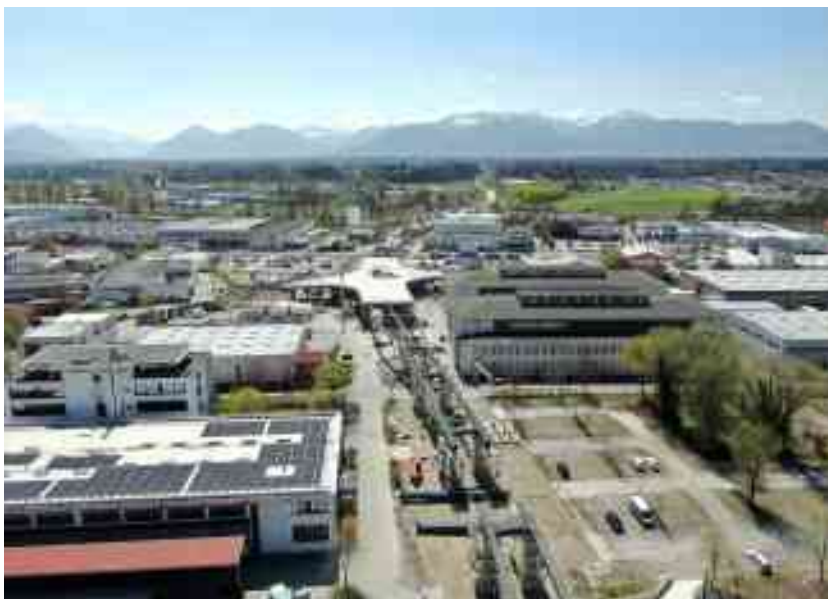
Bild 1 Enges Baufeld durch das Gewerbegebiet des Aicherparks; im Hintergrund kann die seilverspannte Brücke über Mangfall und Mangfallkanal gesehen werden © Ingenieurbüro Grassl GmbH
