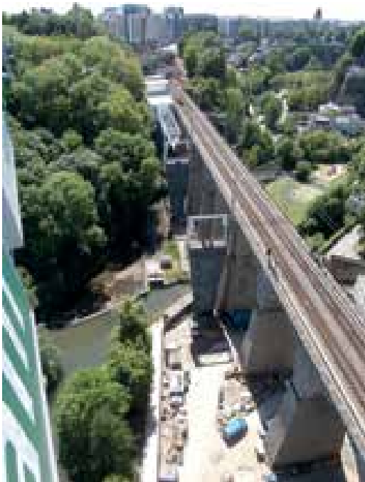
21 22 Einschleppen der Stahlfachwerkstruktur © TR-Engineering S.A.
