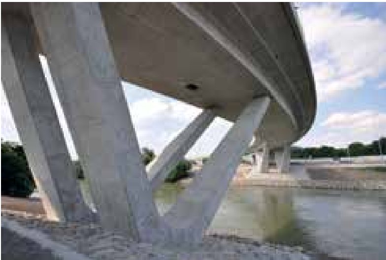
18 Südseitiges Entflechtungsbauwerk am Knoten Prater in Wien © Michael Kleiser
