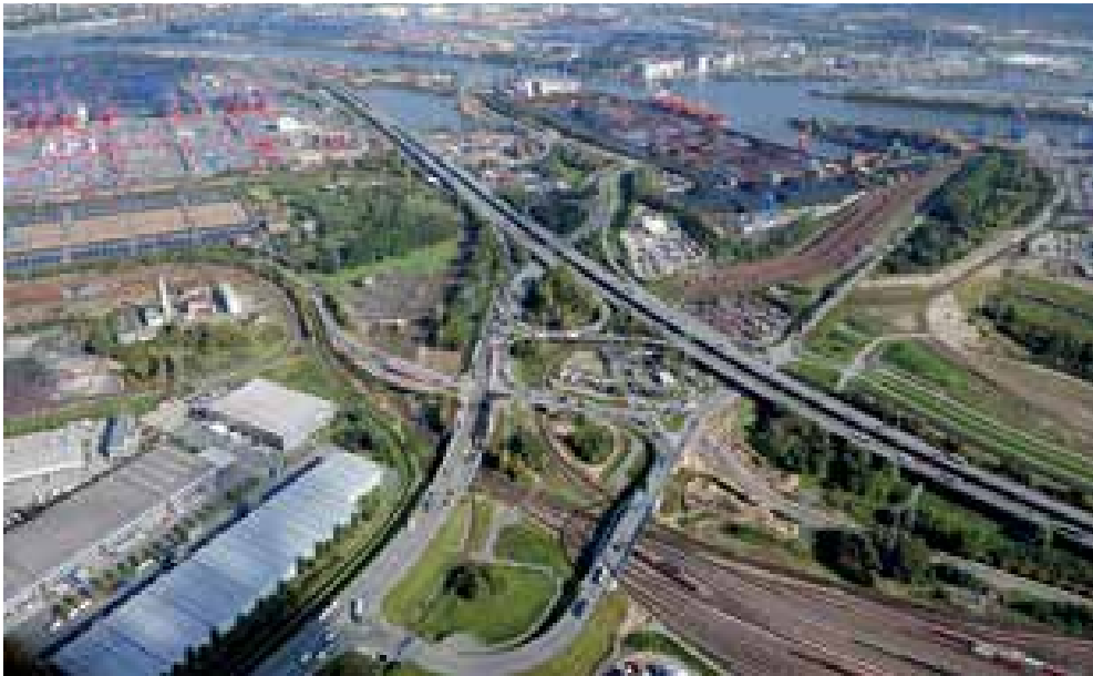
1 Deutschlands längste Straßenbrücke: Hochstraße Elbmarsch mit Anschlussstelle Hamburg-Waltershof © Landesbetrieb Straßen, Brücken und Gewässer Hamburg
