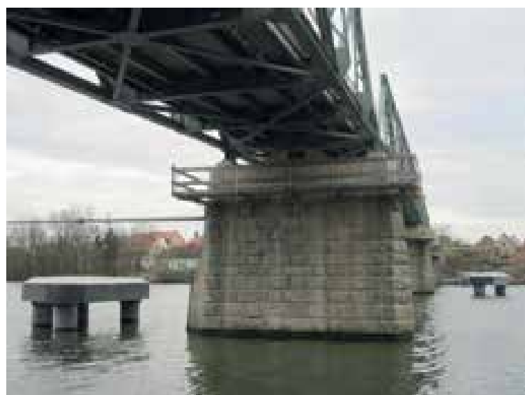
12 Schutzbauwerke nach Fertigstellung © Büchting + Streit AG
