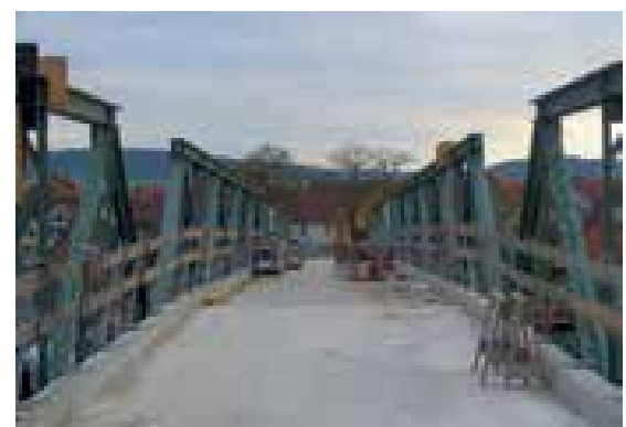
17 Fahrbahnplatte (kurz) nach Fertigstellung © Büchting + Streit AG
