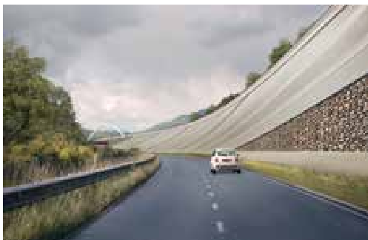
5 Verkleidung aus Beton und Bruchstein © Knight Architects
