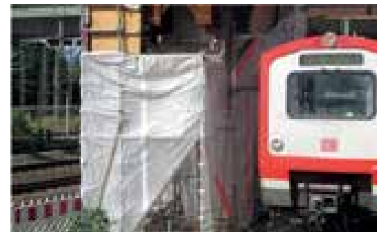
16 S-Bahn-Verkehr an der Hilfsstütze H3 © Hochtief
