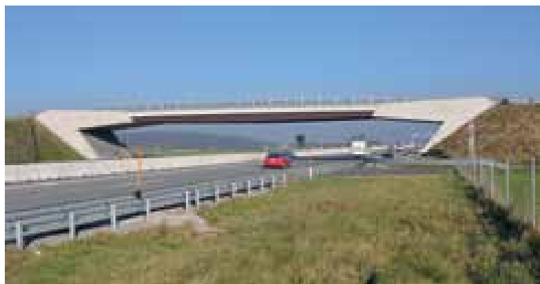
10 Überführungsbauwerk über die A 1 bei Schörfling © Michael Kleiser
