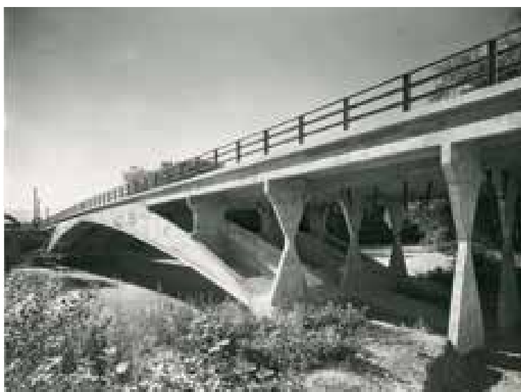
8 Brücke über die Arve bei Vessy mit spielerisch überzeichneten Stützenformen © ETH Zürich
