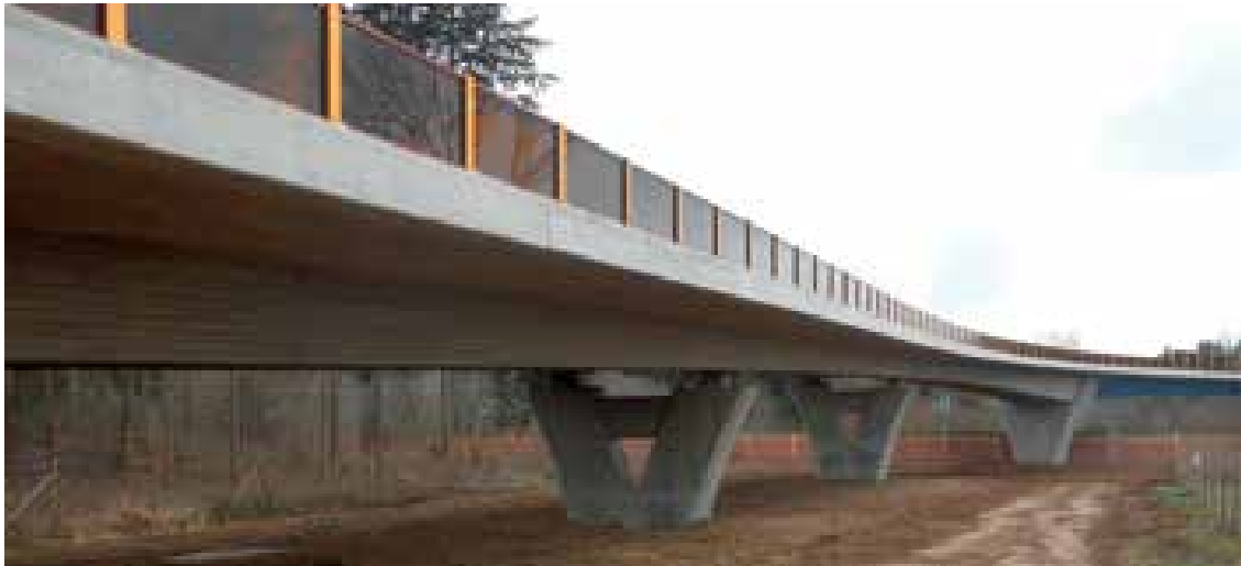
15 Blick auf die fertiggestellte Brücke vom Widerlager in Achse 80 © Wolff & Müller Ingenieurbau GmbH
