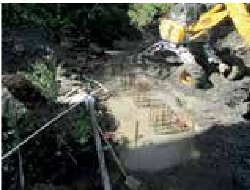
14 Herstellung des Hilfsstützenfundaments © Konstruktionsgruppe Bauen AG
