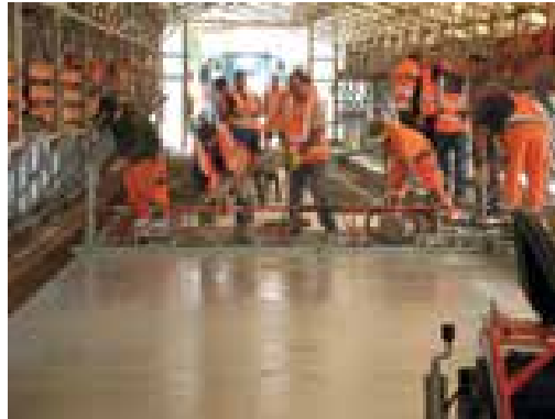
6 UHPC-Einbau im Schutzzelt © Regierungspräsidium Karlsruhe
