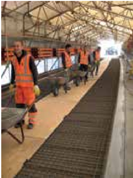
5 Anlieferung des hochfesten Betons © Regierungspräsidium Karlsruhe
