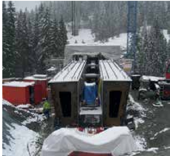
11 Baustelle im Juni 2015 © Konstruktionsgruppe Bauen AG
