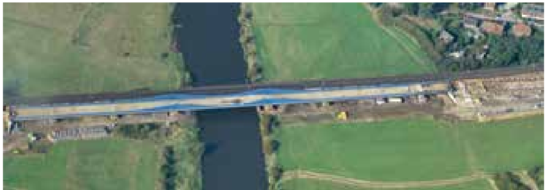
14 Überbau nach Takt 8 in Endlage © Max Bögl Bauunternehmen GmbH
