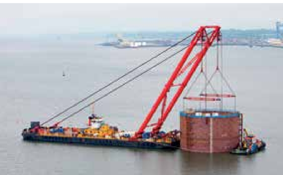
7 Absenken der Pylongründungen © Forth Crossing Bridge Constructors
