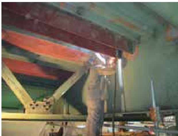
8 Einbau von Längsrippen unter geändertem Fahrzeugrückhaltesystem © Autobahndirektion Südbayern
