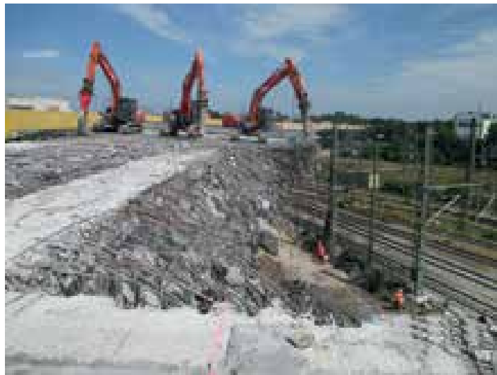
4 Abbruch der Kragarme von oben © Hochtief
