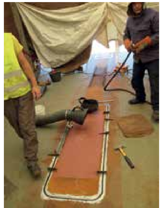
9 Orthotrope Platte: Deckblechaustausch an der Mittelkappe © Autobahndirektion Südbayern
