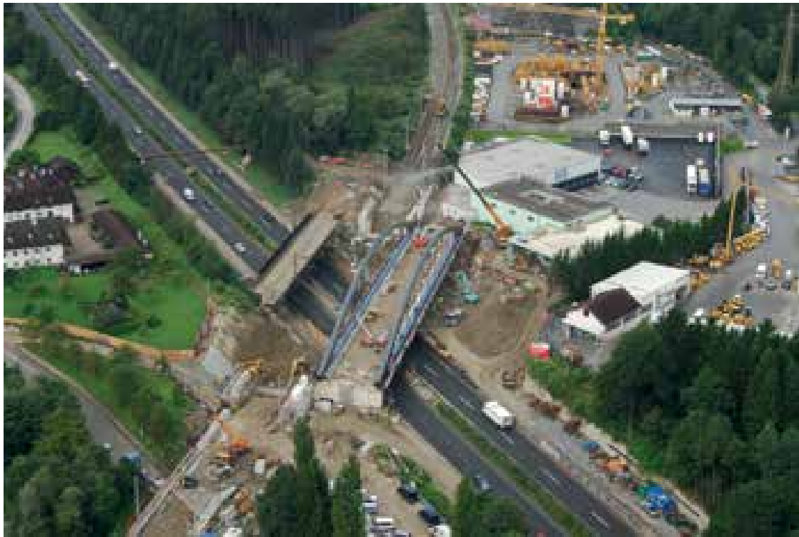
22 Bauphase mit ausgeschobenem Bestandstragwerk © ÖBB-Infrastruktur AG
