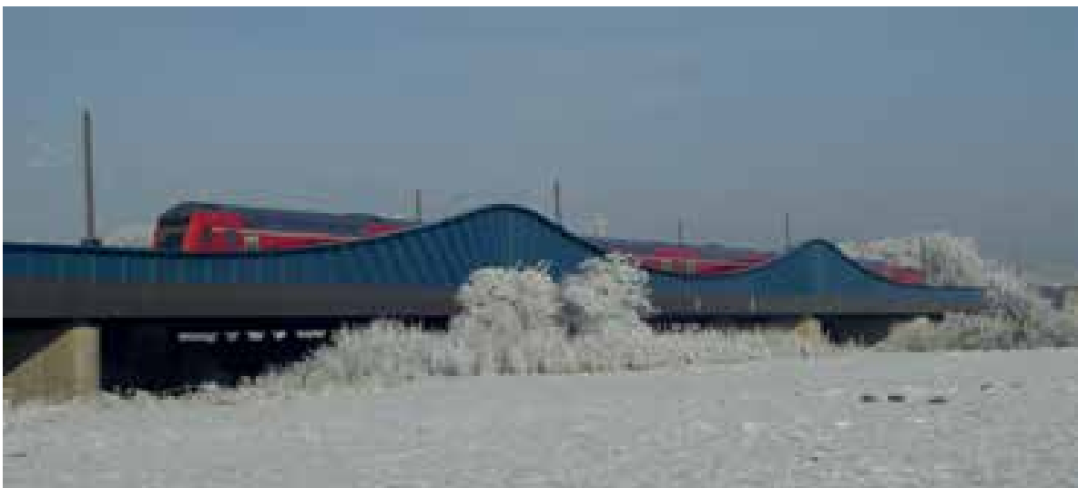
15 Längsträger mit elegantem Schwung der Wellen über der Aller © Erich Schwinge
