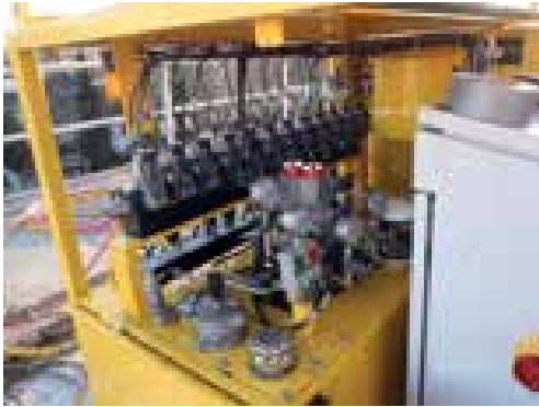
11 Hydraulikpumpe der Synchronhebeanlage © Hochtief
