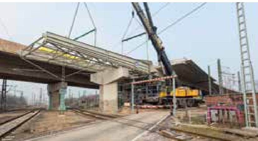
17 Montage des Nachlaufschnabels © Hochtief
