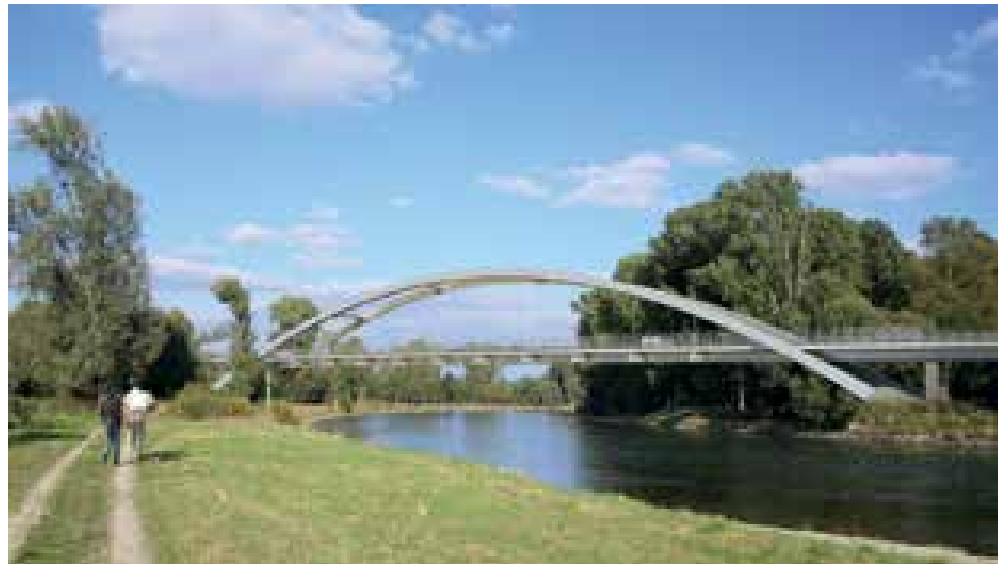
1 Erdgestütztes Bogentragwerk über dem Stromfeld © Ingenieurbüro Grassl GmbH
