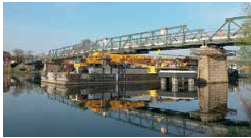
14 Montage des Opferverbandes © Adam Hörnig Baugesellschaft mbH & Co. KG
