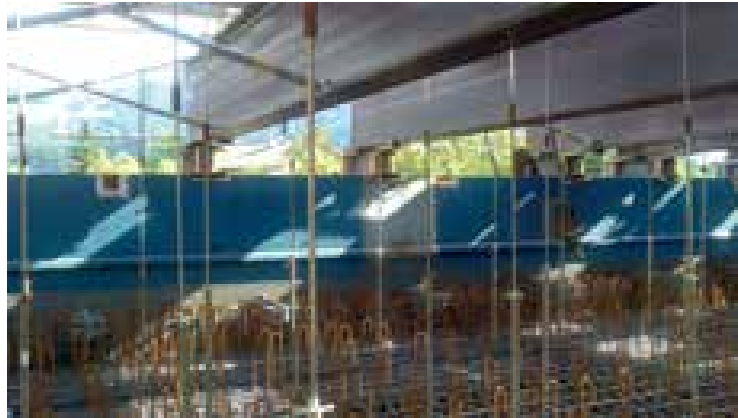
18 Abhängung der Rüstung © ÖBB-Infrastruktur AG
