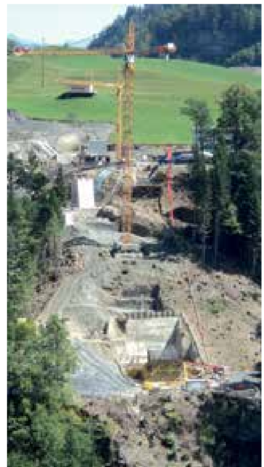
6 Betonieren der Kämpfer © Tiefbauamt Kanton St. Gallen
