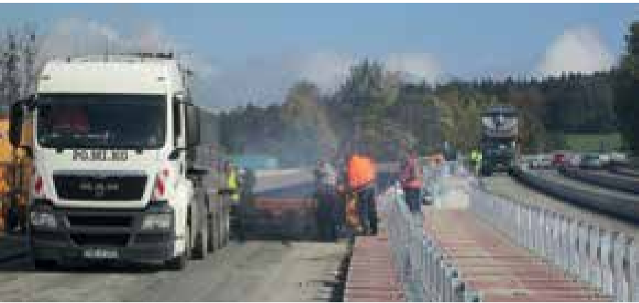
12 Einbau der Schutzschicht aus Gussasphalt © Autobahndirektion Südbayern
