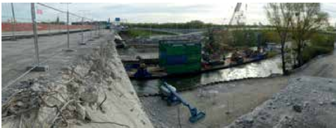
7 Abbruch der alten Brücke mittels Stelzenponton © ASFINAG Baumanagement GmbH
