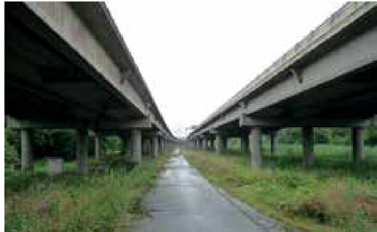
2 Bestehendes Bauwerk samt »Lücke« in der Mitte © DEGES
