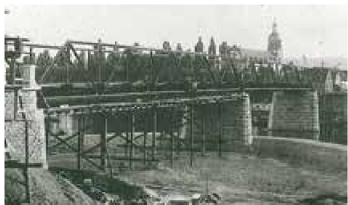
3 Montage der Eisenkonstruktion im September 1884 © Markt Zellingen
