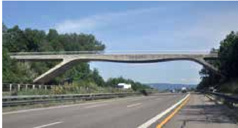
9 Autobahnüberführung bei Kirchheim an der Teck © Michael Kleiser
