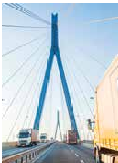
Erneuerung: Fahrbahn, Kappen und Geländer © Klaus Nather/Sika Deutschland GmbH
