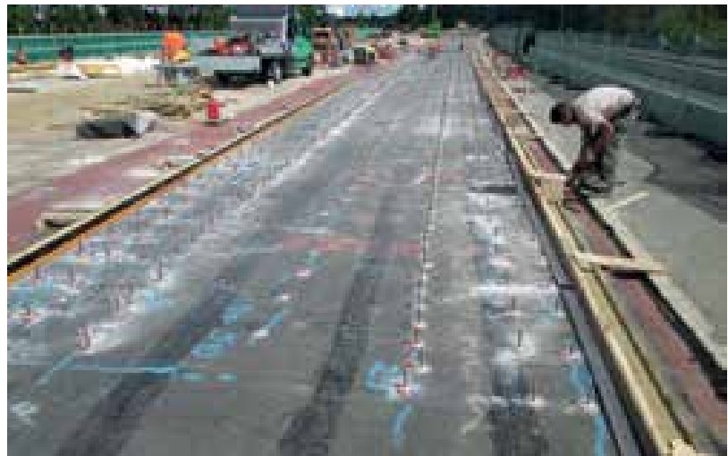
11 Verbundplatte: Injektionsklebeanker im Kappenbereich © Autobahndirektion Südbayern
