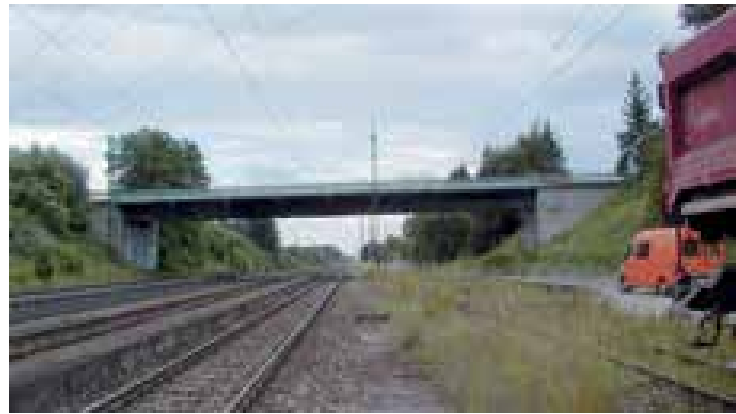
2 Bahnbrücke Beimerstetten nördlich von Ulm © Regierungspräsidium Karlsruhe
