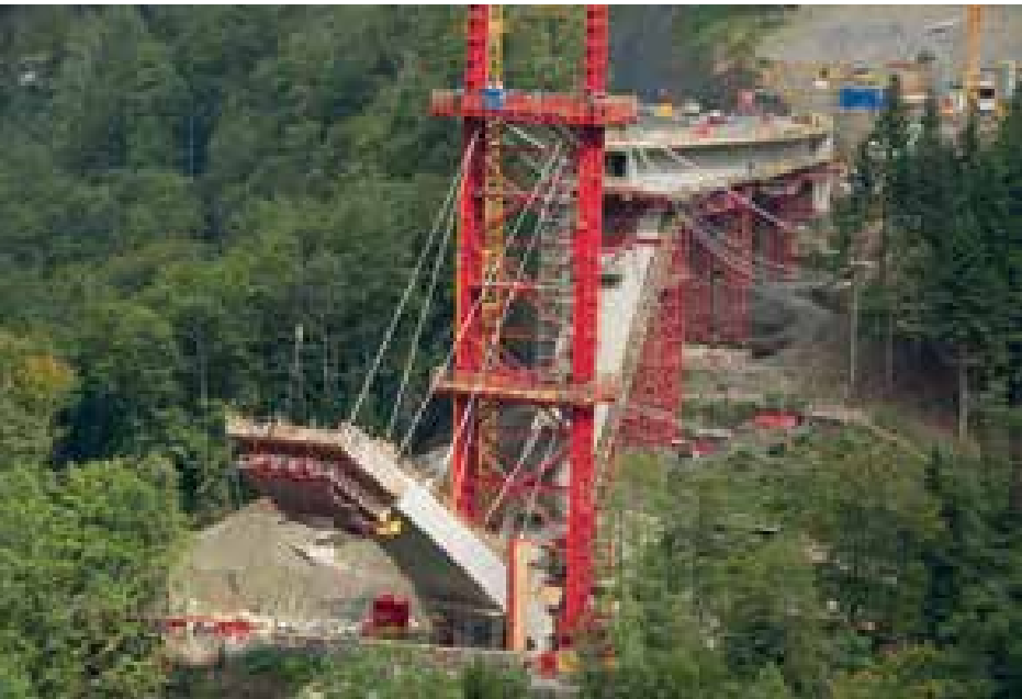
8 Pylon und Traggerüste im Randfeld bei Pfäfers © Leonhardt, Andrä und Partner AG
