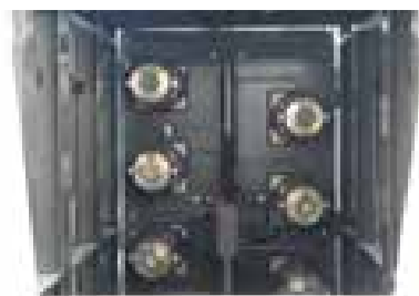
32 33 Heben der Brücke mittels Litzen und Einführen des Pulling-Block in die Steel-Box © Waagner-Biro Bridge Systems AG
