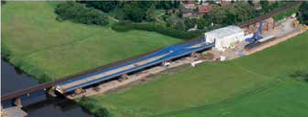
13 Position des Überbaus vor Takt 6 © Max Bögl Bauunternehmen GmbH
