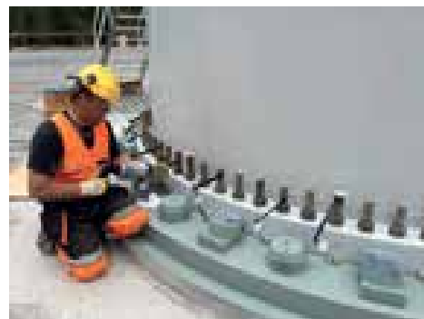
Anwendung: Injektion des flüssigen Materials © Diamant Metallplastic GmbH
