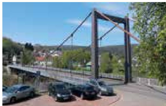
■ Ertüchtigung der Hängebrücke über die Saar in Mettlach © Eiffel Deutschland Stahltechnologie GmbH
