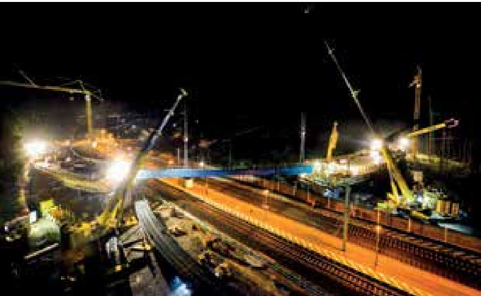
14 Einheben der Stahlverbundträger © Eisele AG
