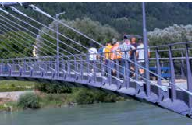
12 Überqueren der Brücke im Gleichschritt © Revotec zt gmbh
