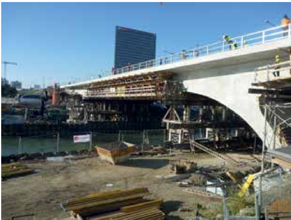
9 Neue Erdberger Brücke im Bauzustand © ASFINAG Baumanagement GmbH
