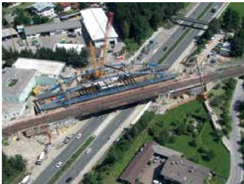
16 17 Montage des Stahlbogens © ÖBB-Infrastruktur AG
