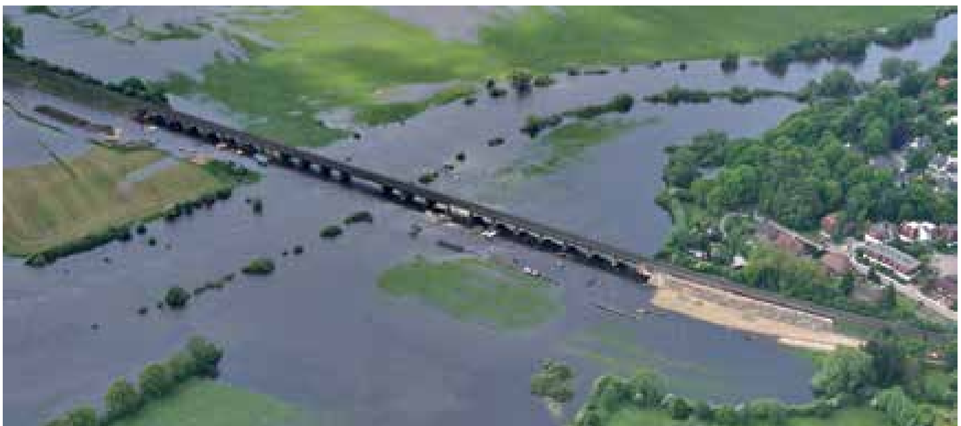
8 Hochwasser Ende Mai 2013, Taktkeller in Vorbereitung © DB ProjektBau GmbH
