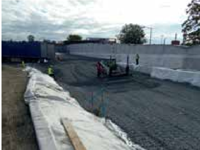
6 Einbau von Glasschaumgranulat © ASFINAG Baumanagement GmbH
