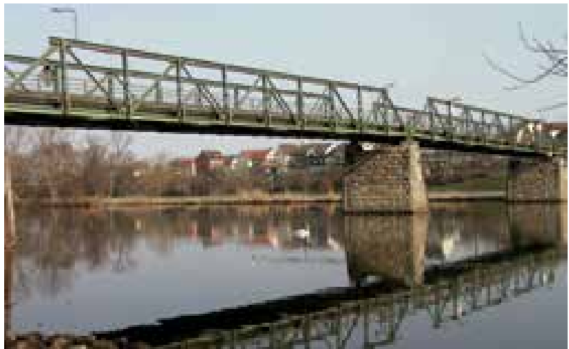
4 Erscheinungsbild vor der Sanierung © Büchting + Streit AG
