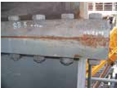
Nach DIN ausgeführter Flanschstoß mit Futterblech © Diamant Metallplastic GmbH
