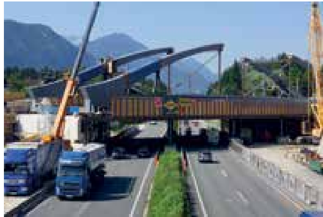
15 Schutzgerüst über der Autobahn © ÖBB-Infrastruktur AG
