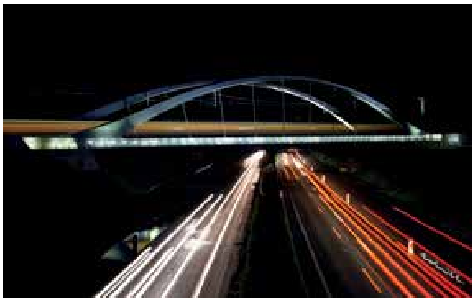
23 24 Erscheinungsbild der fertiggestellten Brückenkonstruktion bei Tag und Nacht © ÖBB-Infrastruktur AG
