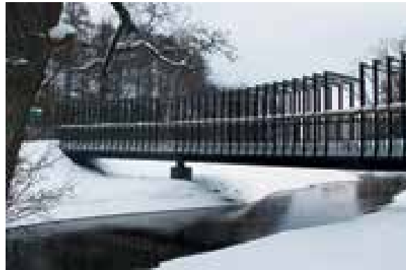
■ Stegkonstruktion ohne Korrosionsgefahr © Brückner & Brückner Architekten/Institut Feuerverzinken GmbH
