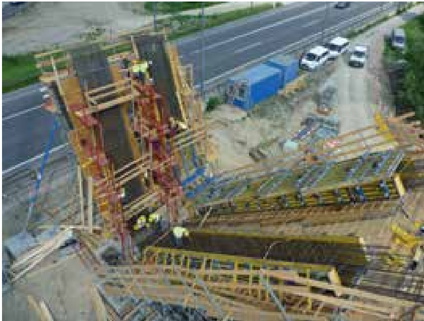
5 Entflechtungsbauwerk: Errichtung der V-Stützen © ASFINAG Baumanagement GmbH
