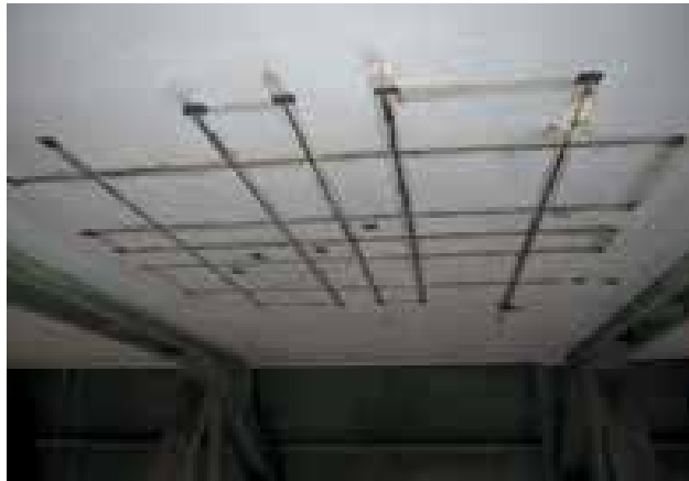
7 Verbundplatte: Belastungsversuch mit applizierten Sensorfasern im Messfeld © Prof. Fischer Ingenieure GmbH
