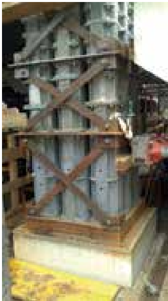
19 20 Stapeltürme zur provisorischen Lagerung © ÖBB-Infrastruktur AG
