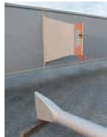
Trapezhänger und Anschlussblech vor dem Verschweißen.
