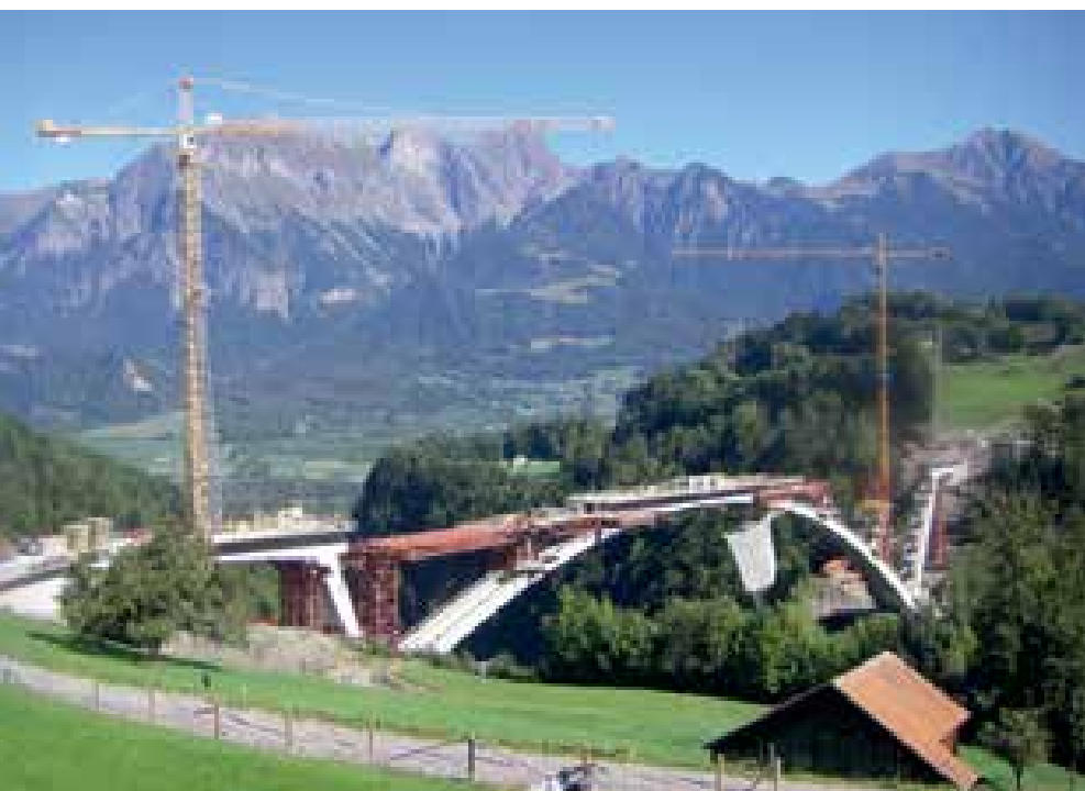
18 Überbauerstellung über dem Bogen mittels Traggerüsts © Leonhardt, Andrä und Partner AG
