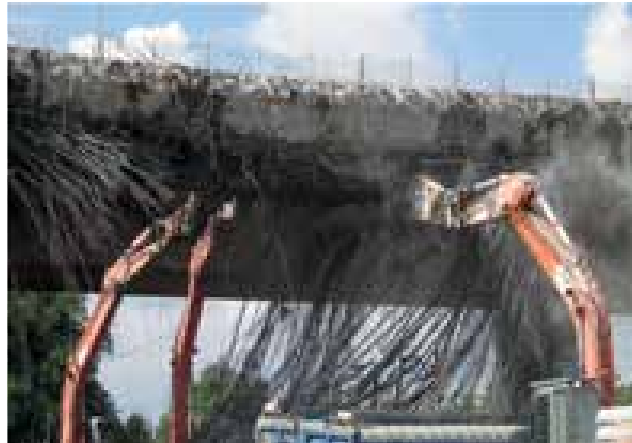
8 Schwächen der Hohlkastenstege mit Baggern © Hochtief
