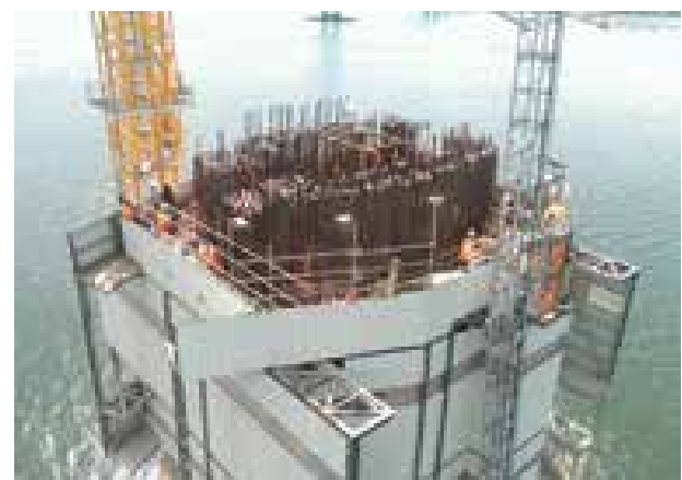
8 Kletterschalung zur Pylonspitzenerrichtung © Forth Crossing Bridge Constructors
