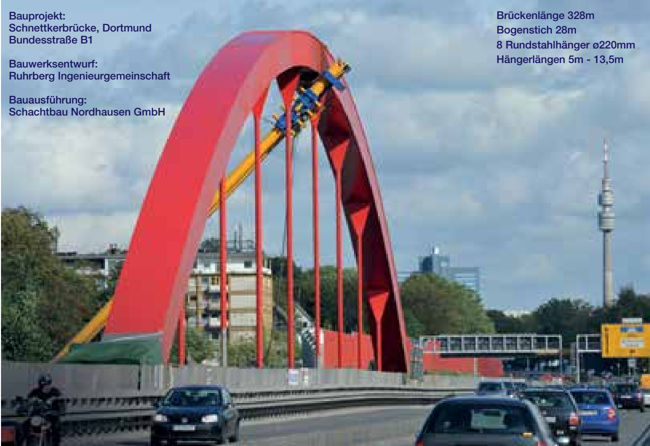
Aufstellen des Bogens
