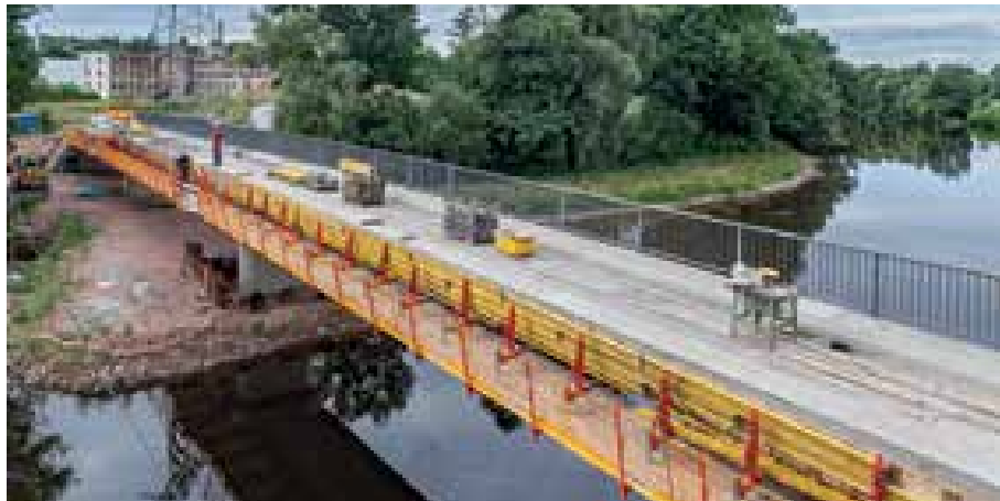
■ Errichtung der Radwegbrücke aus Stahlbeton © Peri GmbH
