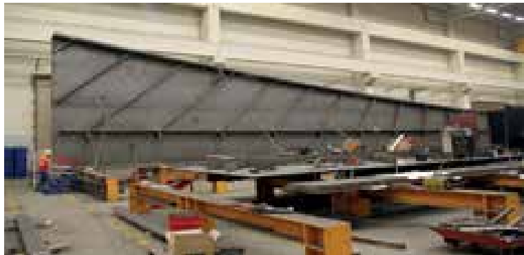
11 Längsträgersegment in der Werksvorfertigung © Max Bögl Bauunternehmen GmbH
