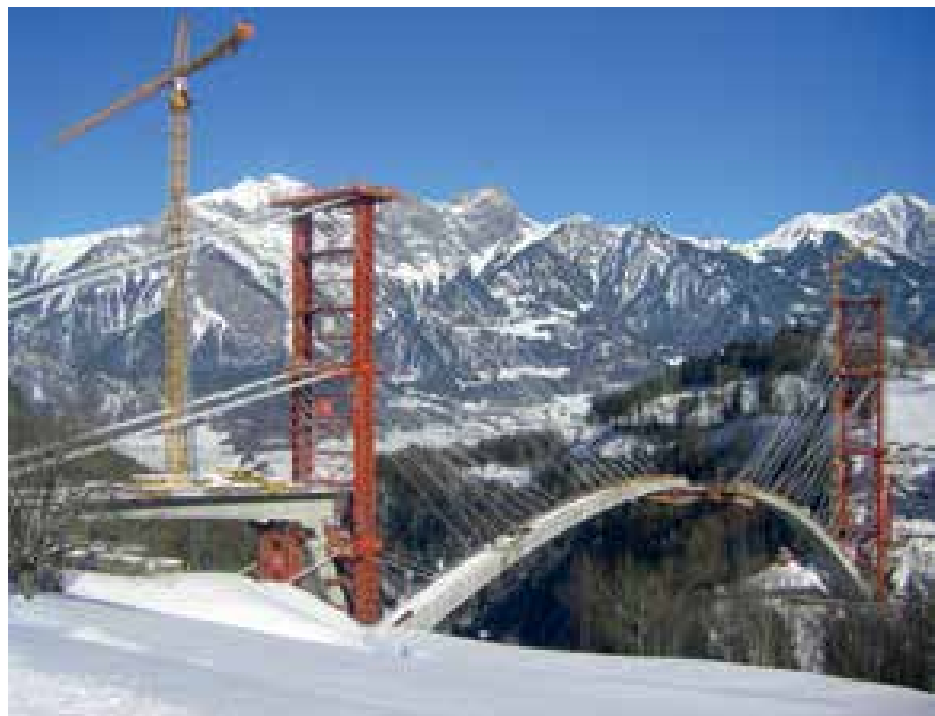
11 Temporäre Abspannung des Bogens © Leonhardt, Andrä und Partner AG
