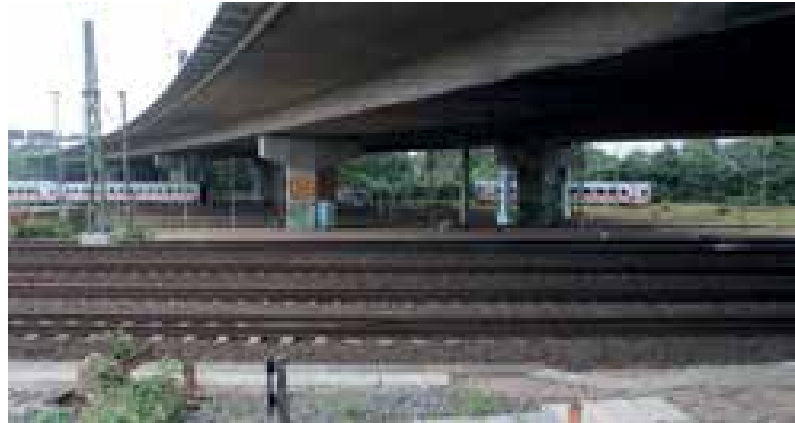
1 Langenfelder Brücke vor Errichtung des Ersatzneubaus © Hochtief
