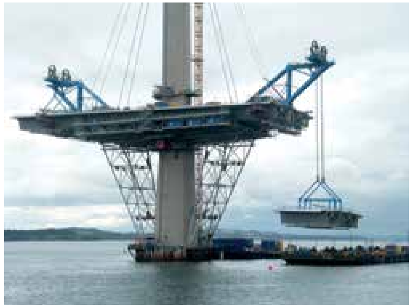
10 Einheben eines typischen Verbundsegments © Forth Crossing Bridge Constructors
