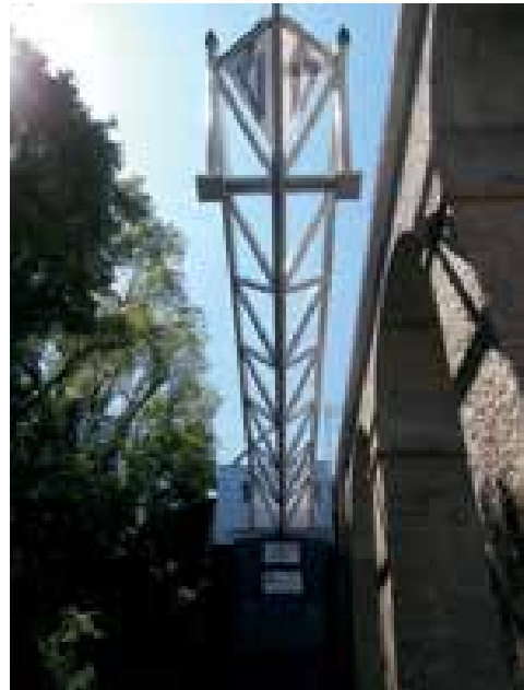
21 22 Einschleppen der Stahlfachwerkstruktur © TR-Engineering S.A.
