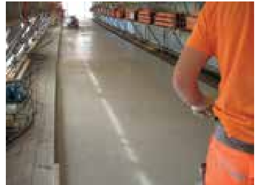
7 Betonierabschnitt nach Fertigstellung © Regierungspräsidium Karlsruhe
