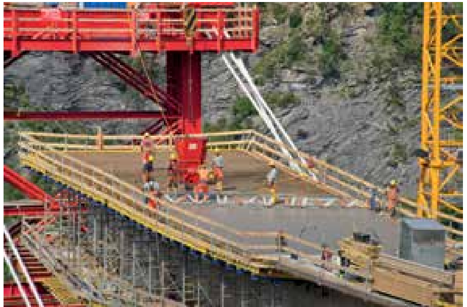
15 Betonieren des Überbaus im Randfeld © Tiefbauamt Kanton St. Gallen
