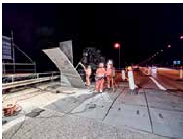
■ Einsatz von modularen Baustellenüberbrückungen © Maurer AG/Erik Krüger
