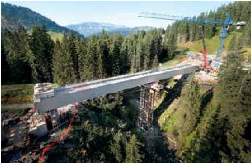
13 Endverschub des Überbaus © Eva Bartussek
