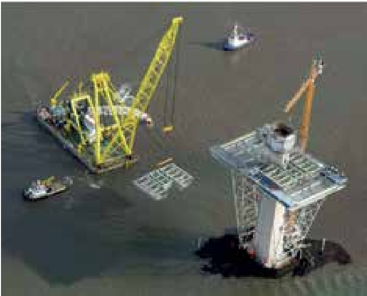
9 Einheben der Startersegmente © Forth Crossing Bridge Constructors
