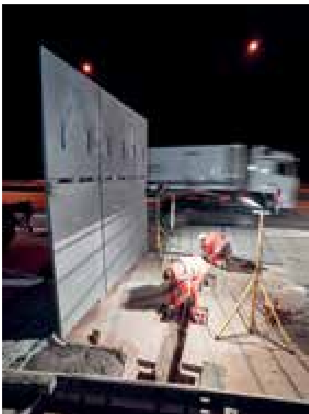
■ Vorbereitende Arbeiten am (vorhandenen) Bauwerkspalt © Maurer AG/Erik Krüger
