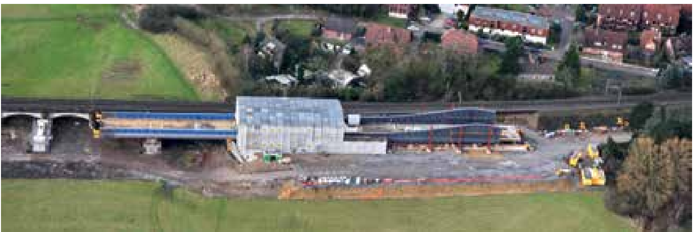
12 Taktkeller mit Einhausung, Position des Überbaus nach Takt 2 © Max Bögl Bauunternehmen GmbH
