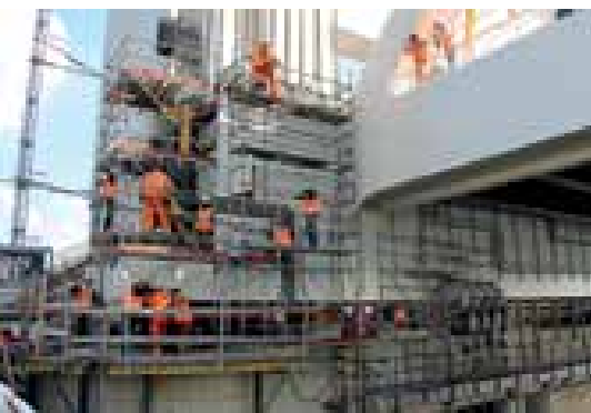
30 31 Montage von Guiding-Box und Seilköpfen © Waagner-Biro Bridge Systems AG
