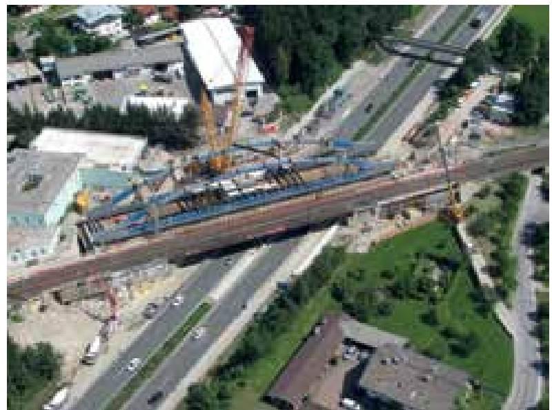
16 17 Montage des Stahlbogens © ÖBB-Infrastruktur AG
