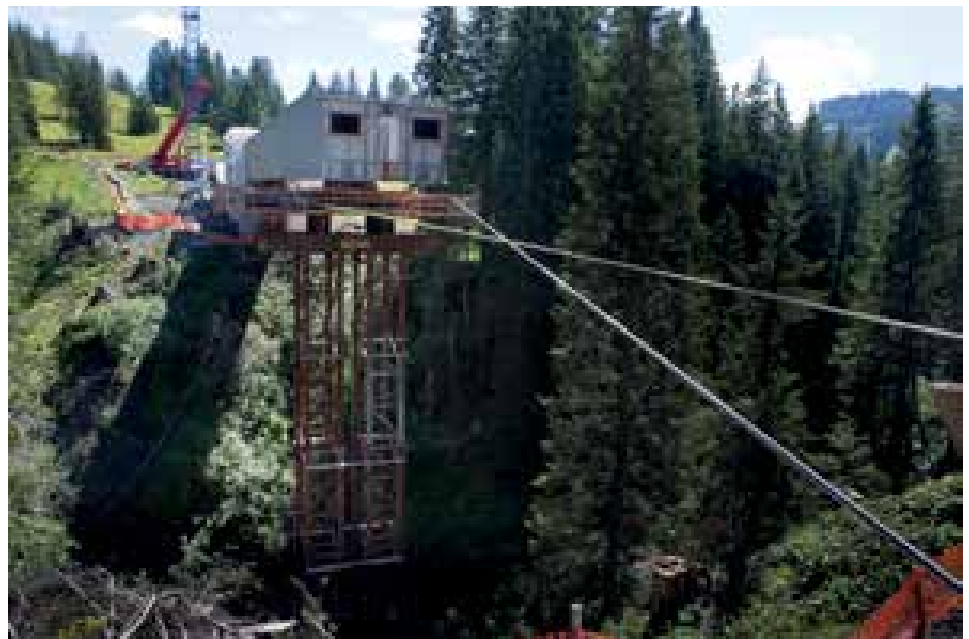
15 Hilfsstütze nach Errichtung © Konstruktionsgruppe Bauen AG
