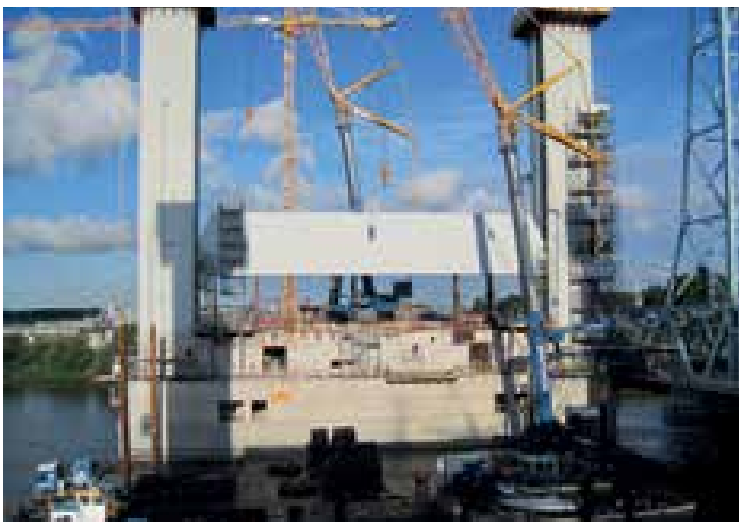
26 27 Einhub der oberen Seilrollen © Waagner-Biro Bridge Systems AG
