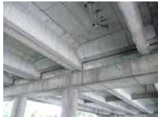
4 Auflagerbereich inklusive Querträgern © DEGES
