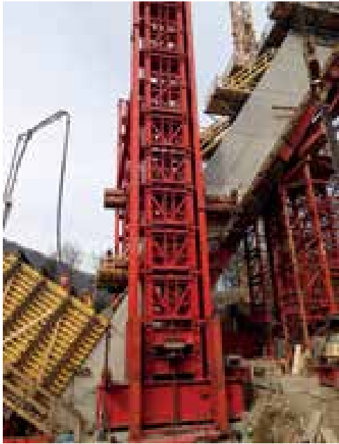
10 Auflager und seitliche Abstützung des Pylons © Lehrgerüstbau GmbH
