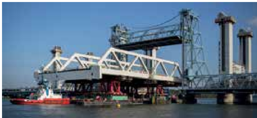
28 29 Auffahren auf den Ponton und Durchfahrt durch die bestehende Botlek-Brücke © Waagner-Biro Bridge Systems AG
