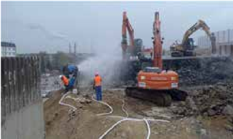
19 Abbruch hinter dem nördlichen Widerlager © Hochtief
