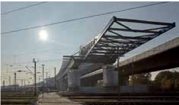
21 Stahlbau-Einschub der neuen Langenfelder Brücke (Ost) © Dominik Reipka
