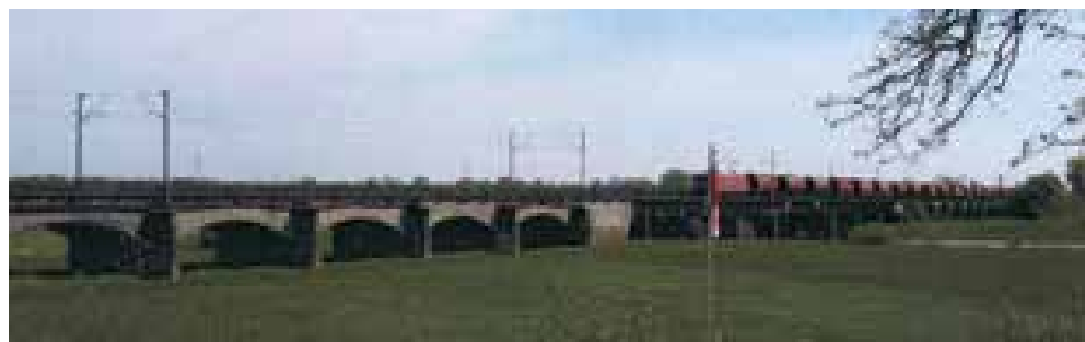
1 Bestandsbrücke mit Gewölbemauerwerk © DB ProjektBau GmbH
