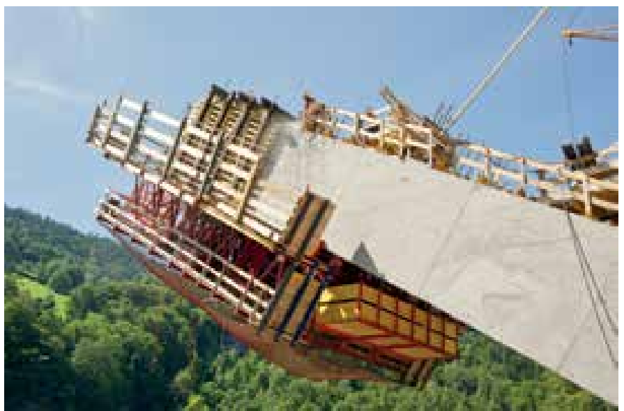
12 Freivorbaugerüst zum Betonieren © Tiefbauamt Kanton St. Gallen
