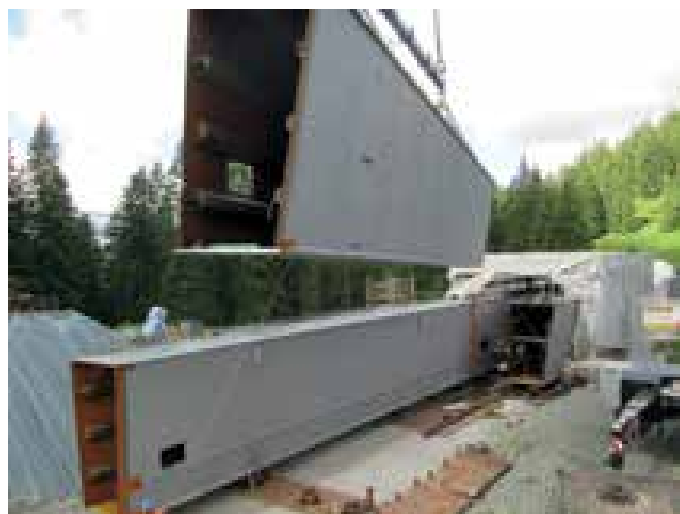
10 Einheben der Stahlhohlkästen © Konstruktionsgruppe Bauen AG
