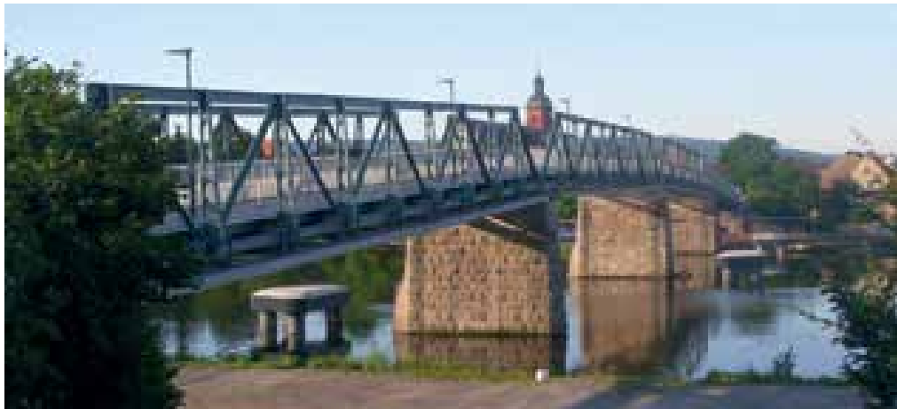
18 Alte Mainbrücke nach Abschluss der Baumaßnahme © Hochreither Vorndran Ingenieurgesellschaft mbH
