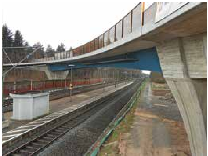
4 Bahnüberspannendes Mittelfeld der Brücke © Wolff & Müller Ingenieurbau GmbH
