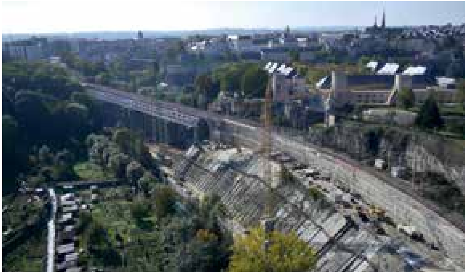
23 Aktueller Bauzustand von Viadukt und Hangkonstruktion © TR-Engineering S.A.
