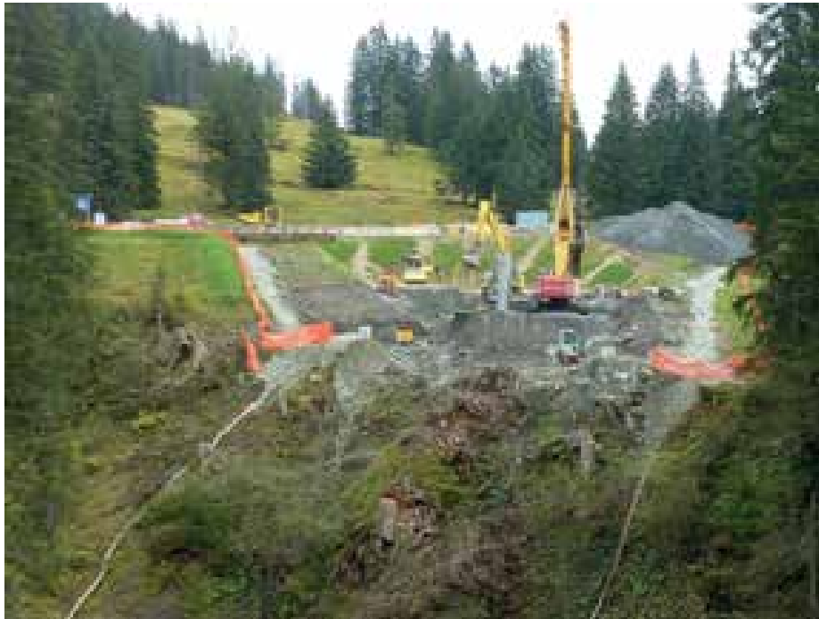
9 Herstellung der Bohrpfähle am Widerlager Obermaiselstein © Konstruktionsgruppe Bauen AG
