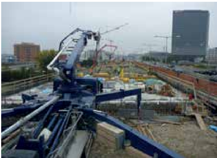
8 Errichtung des neuen Brückentragwerks © ASFINAG Baumanagement GmbH
