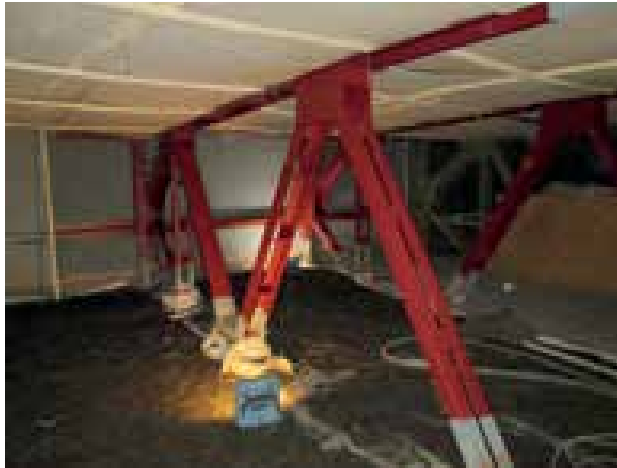
10 Verbundplatte: Korrosionsschutzerneuerung am Fachwerkquerträger © Autobahndirektion Südbayern
