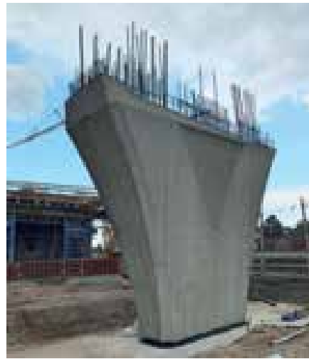
5 6 Semiintegraler Pfeiler in Achse 40 © Holger Hauser, K+S Ingenieur-Consult GmbH & Co. KG
