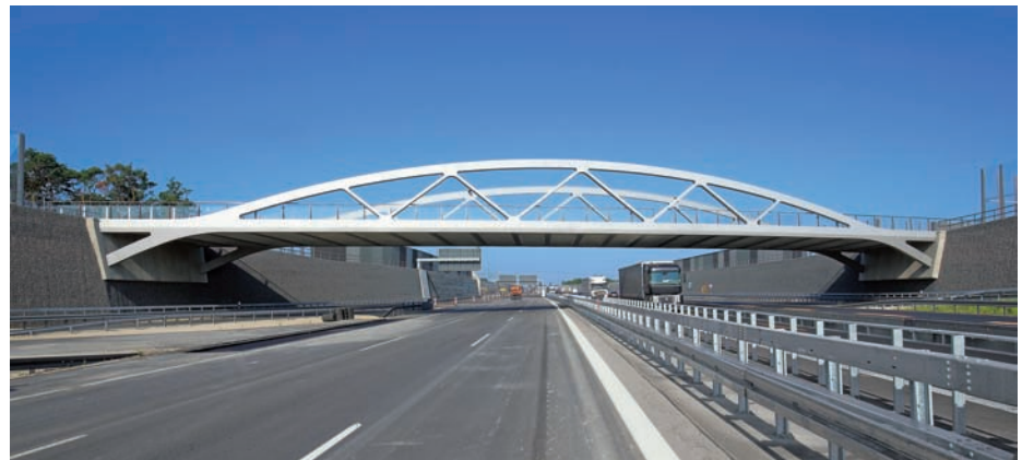
Bild 1: Seitenansicht des Bogenfachwerks (Ingenieurbüro Grassl GmbH, Foto: René Legrand)
