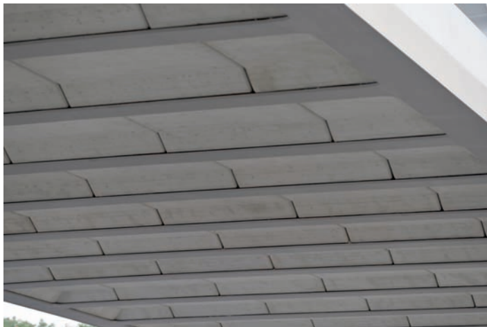
Bild 4: Untersicht des Bauwerks (Ingenieurbüro Grassl GmbH, Foto: Hajo Dietz)
