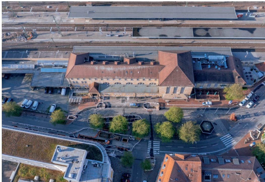
Bild 1: Bahnhofplatz heute: Die aktuelle Situation ist unbefriedigend. Eine Vorfahrt zerschneidet den Platz und schafft den Charakter einer Verkehrsinsel
