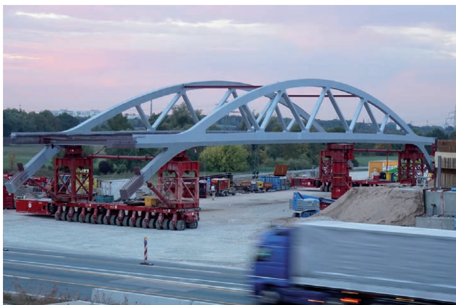
Bild 5: Stahlgerippe kurz vor Einfahrtvorgang (Foto: Samuel Pfenning)
