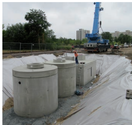
Bild 9: Einbau der Zisternen
